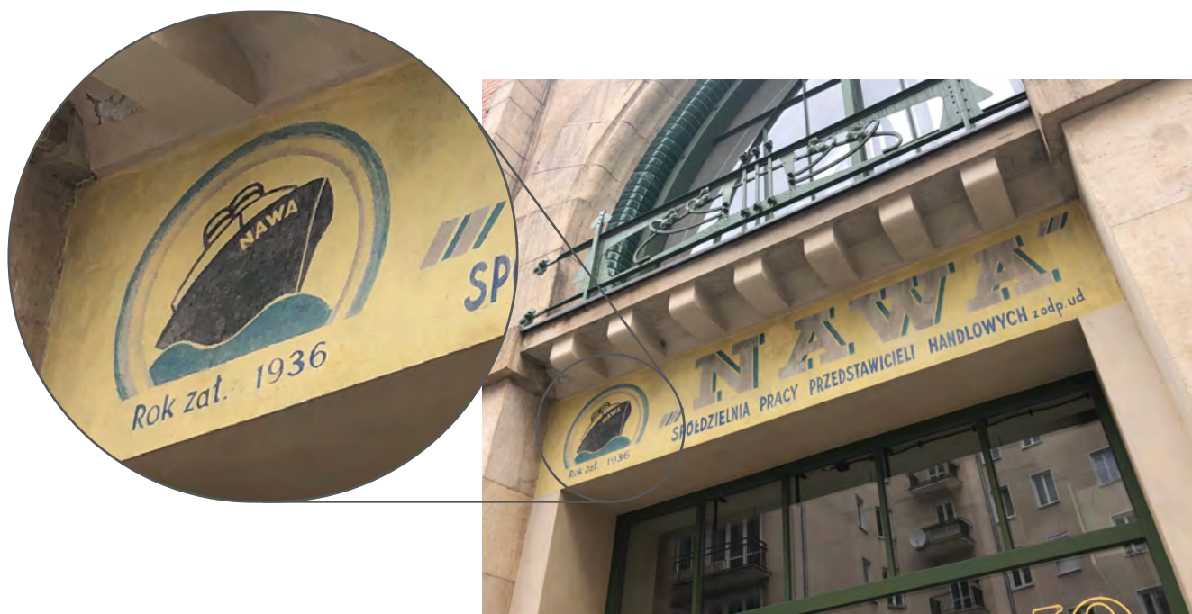
przedwojenna reklama organizacji o tej samej nazwie na budynku hali Koszyki w Warszawie
