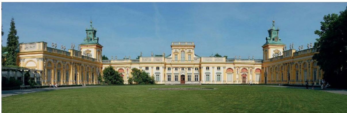
Pałac w Wilanowie
